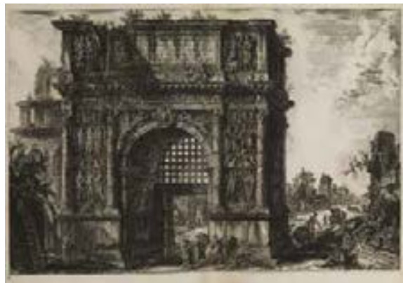
Fig. 59 - G.B. Piranesi, Veduta dell'Arco di Benevento nel Regno di Napoli , ca. 1773
