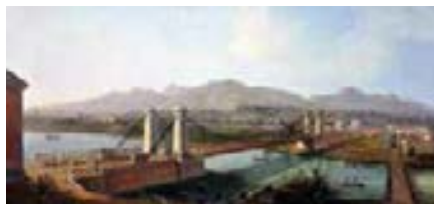
Fig. 2 - F. Fergola (attribuito a), Il ponte del Garigliano, 1833 , collezione privata
