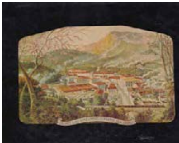
Fig. 45 - MCM, Stabilimenti di Fratte (SA)
