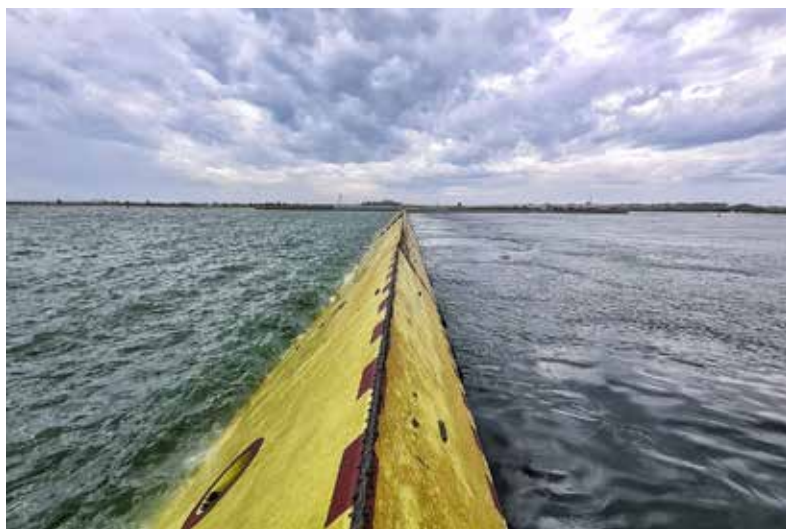
Figura 34 - Le paratie del sistema di dighe mobili MOSE
