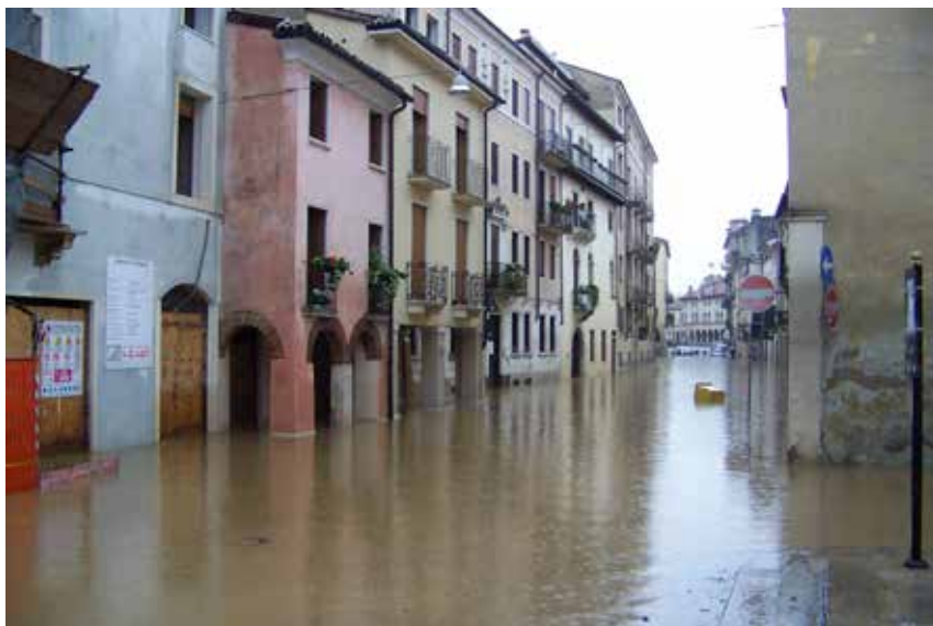
Figura 46 - L'alluvione del 2010 in centro a Vicenza
