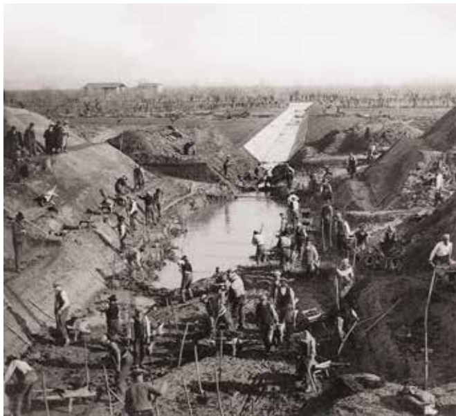
Figura 40 - Scavi per bonifica nel Veronese, anni '20 del Novecento
